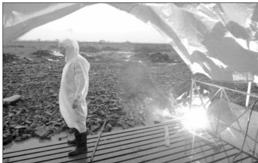
A umidade do terreno poderá impedir a entrada dos equipamentos no local
